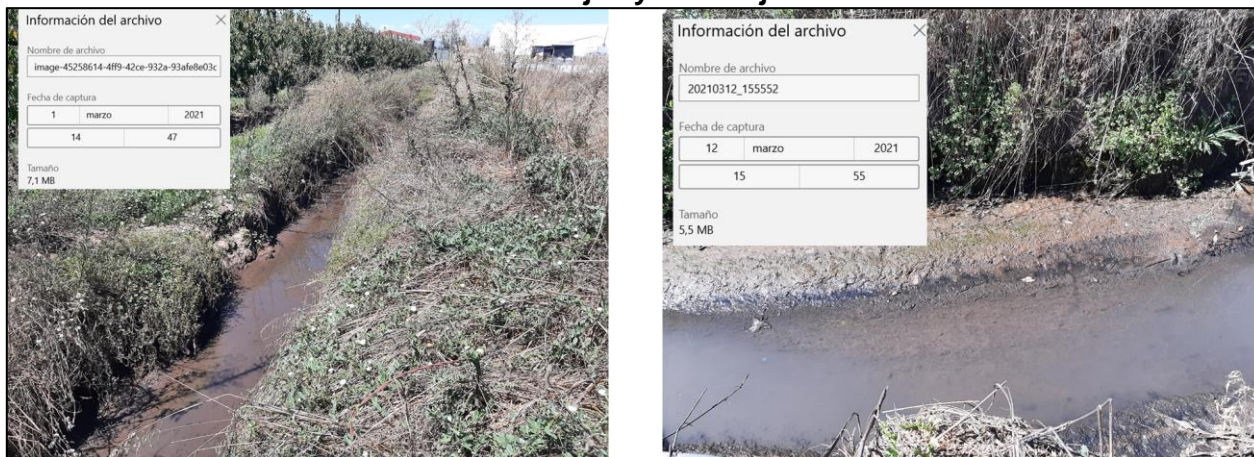
Fotografía 7: Registro de Canal de agua lluvia, con sedimentos propios de tierras y restos de orujos y escobajos
