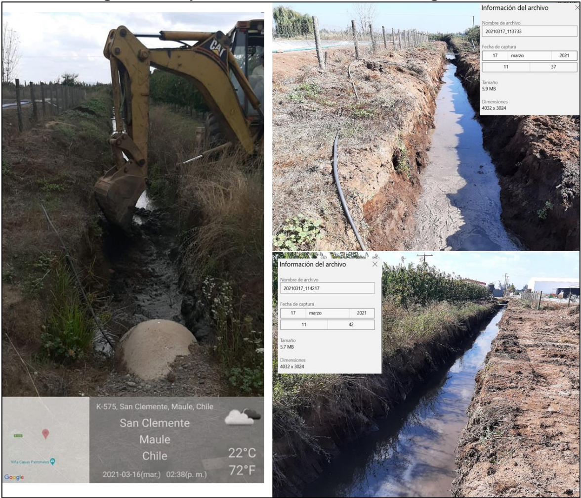
Fotografía 8: Limpieza de sedimentos del canal de aguas lluvias.
